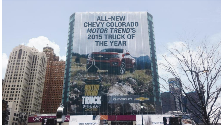
الشكل (51) لافتة تغطي واجهة أحد المباني
