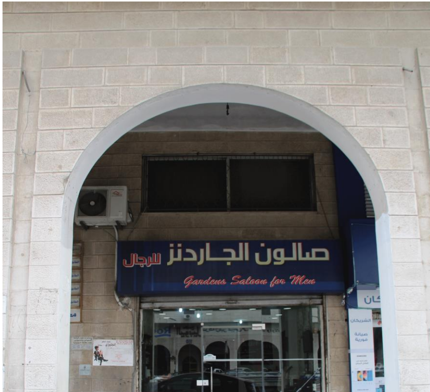
الشكل (61) يبين موقع لافتة تجارية لأحد محال الحلاقة من خارج مبنى الرواق المصدر: (الباحثة، 2019)
